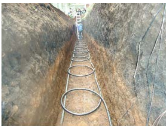
写真 1 バンドン工科大学に設置された 地中熱の地下抽熱部分
