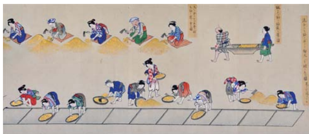
鉱石の粉細とゆり鉢による選別 (「阿仁鉱山銅山働方之図」、鉱業博物館蔵)
