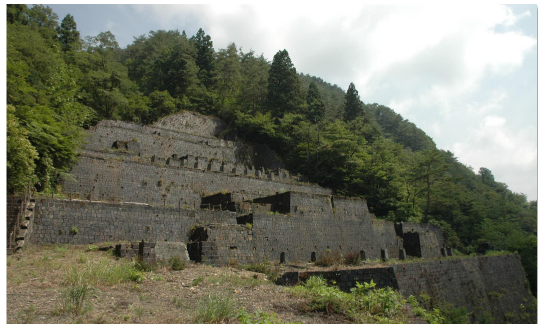
中央選鉱場跡 (現在の様子。建物はなくなり、土台が残されている)
